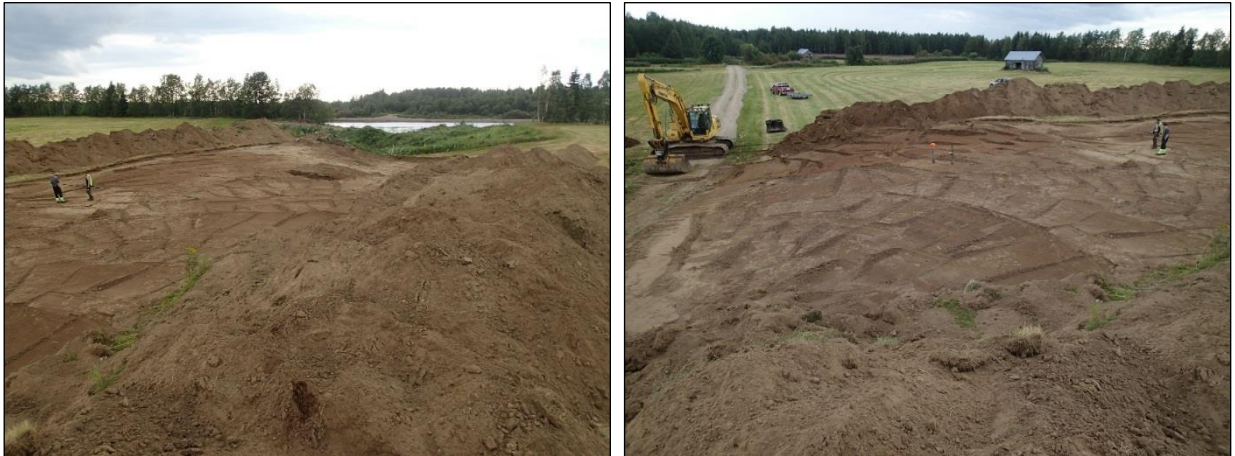
Kuorittua putkilinjaa tutkimusalueella. Pohjoiseen (vas). Kuorittua putkilinjaa tutkimusalueen eteläosassa. Lanteen (oik).
