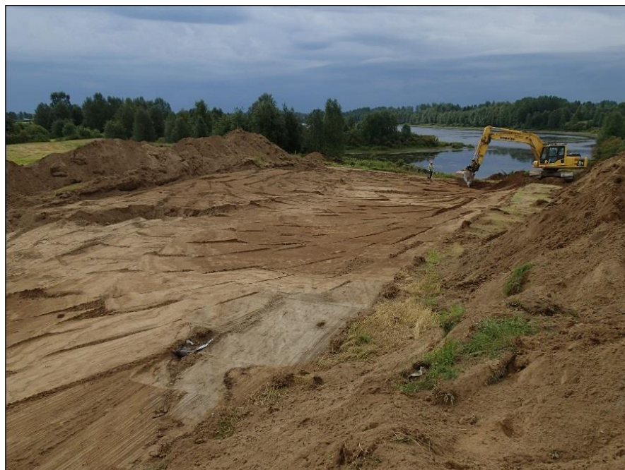
Maa-ainesta kuoritaan tutkimusalueella. Taustalla Kotiuopaja. Etelään.
